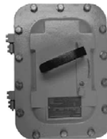
Slika 2. Energetska sklopka u Exd izvedbi
